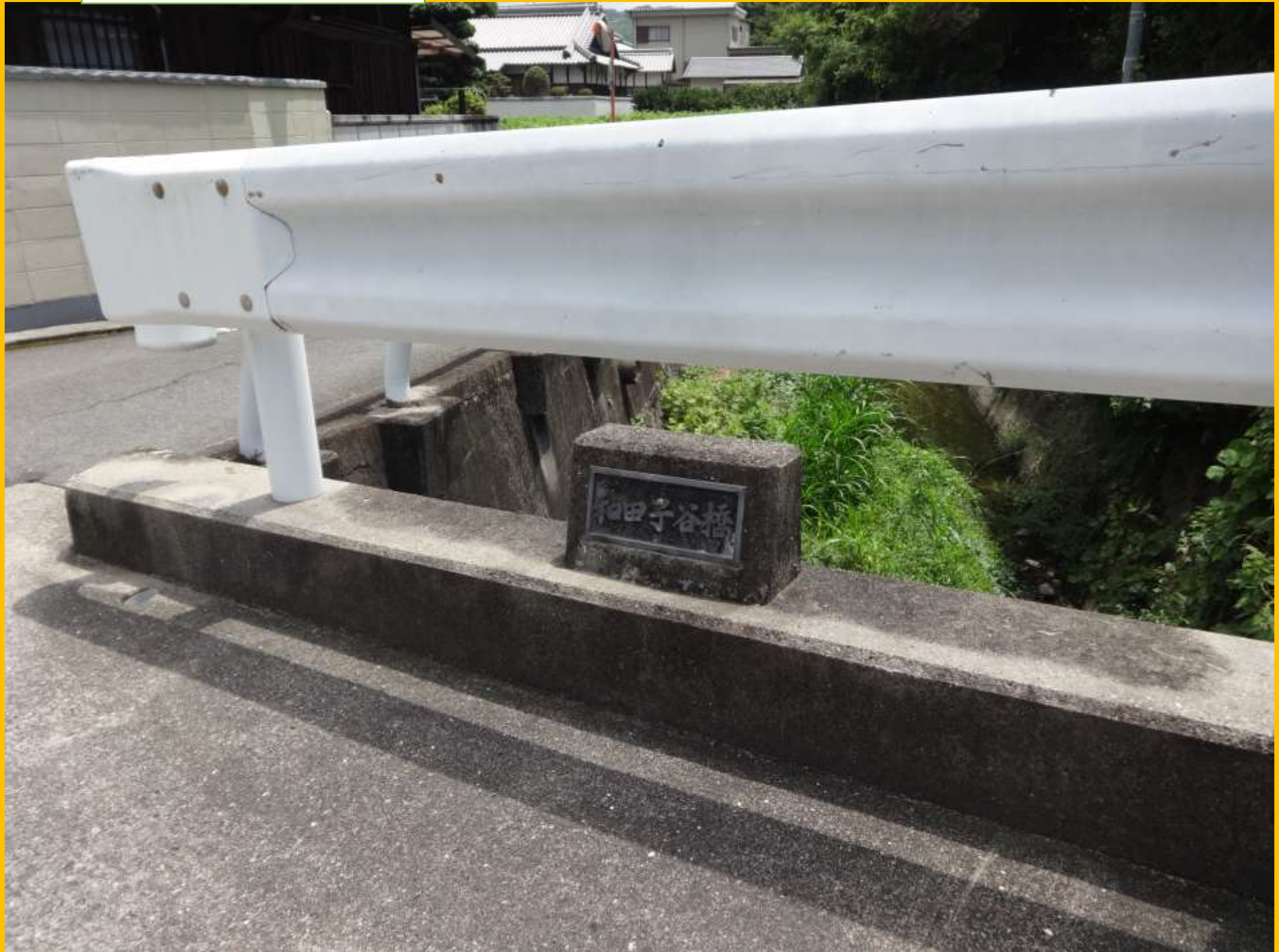
轟川にかかる橋 和田子谷橋
