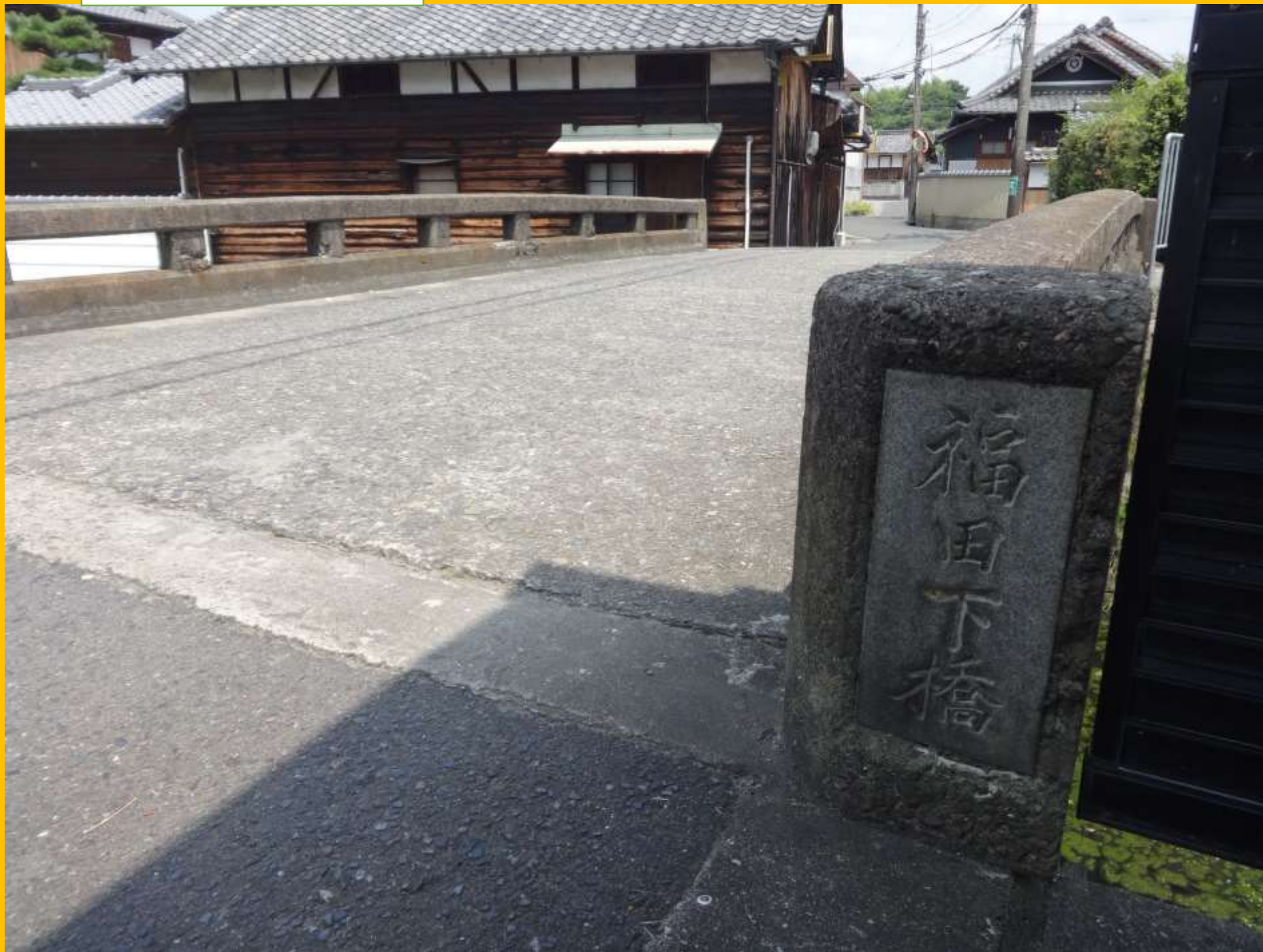
轟川にかかる橋 福田下橋
