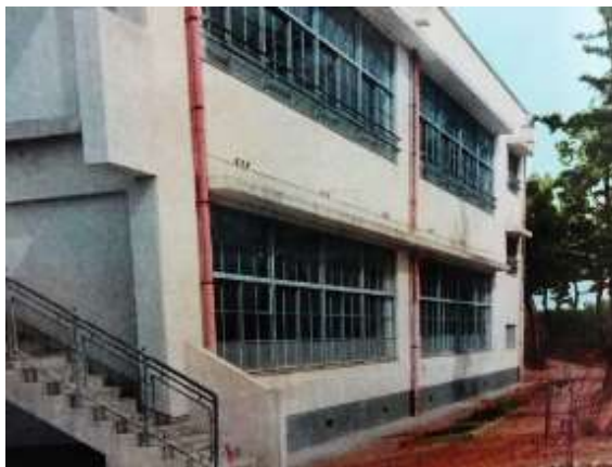
現旧館校舎 昭和 34 年に鉄筋コンクリート 2 階建て 4 教室が新築されました。
