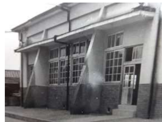
講堂 昭和 56 年に撤去され、その跡地には体育館が建てられています。
