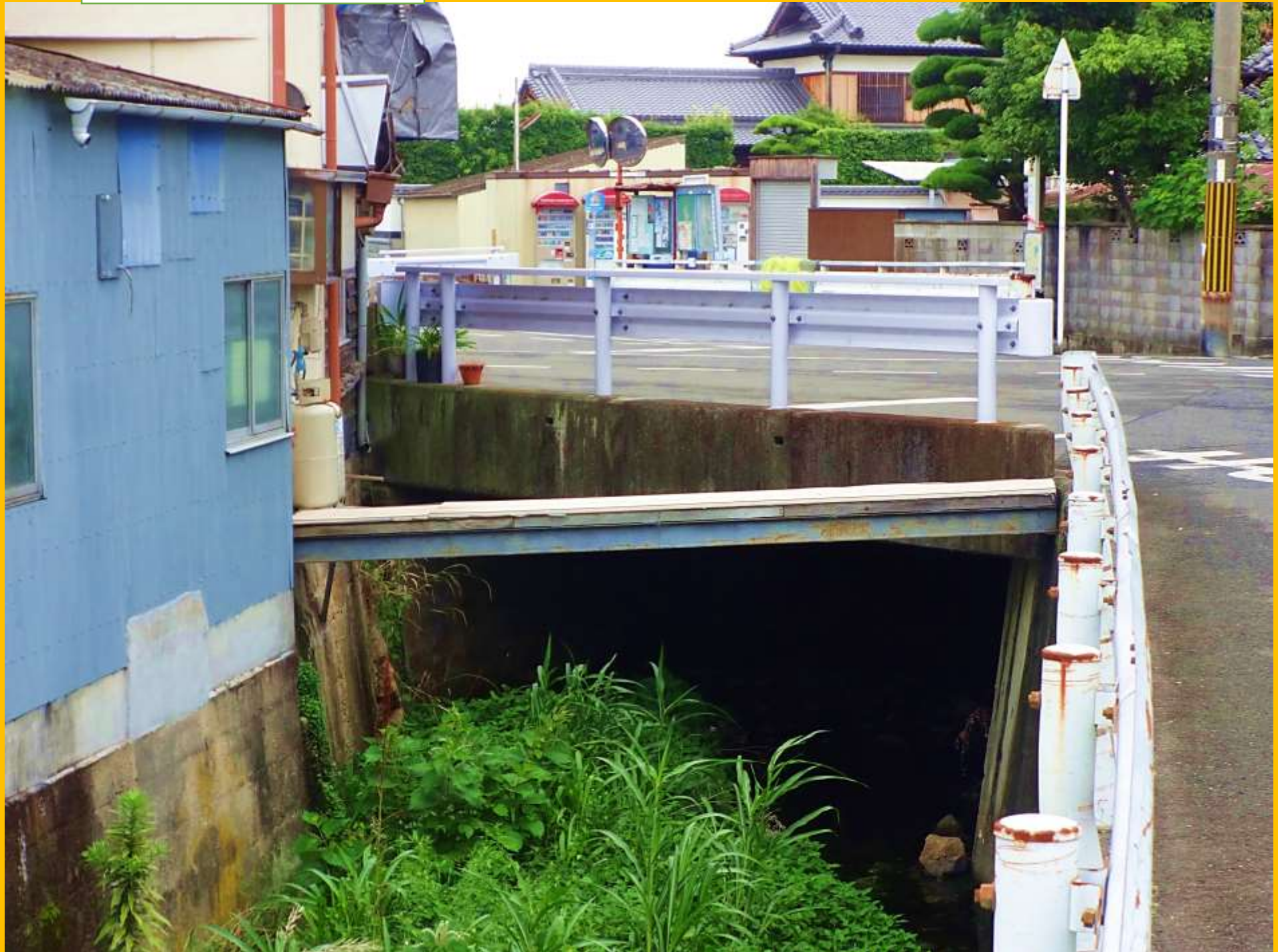
轟川にかかる橋 砂原橋
