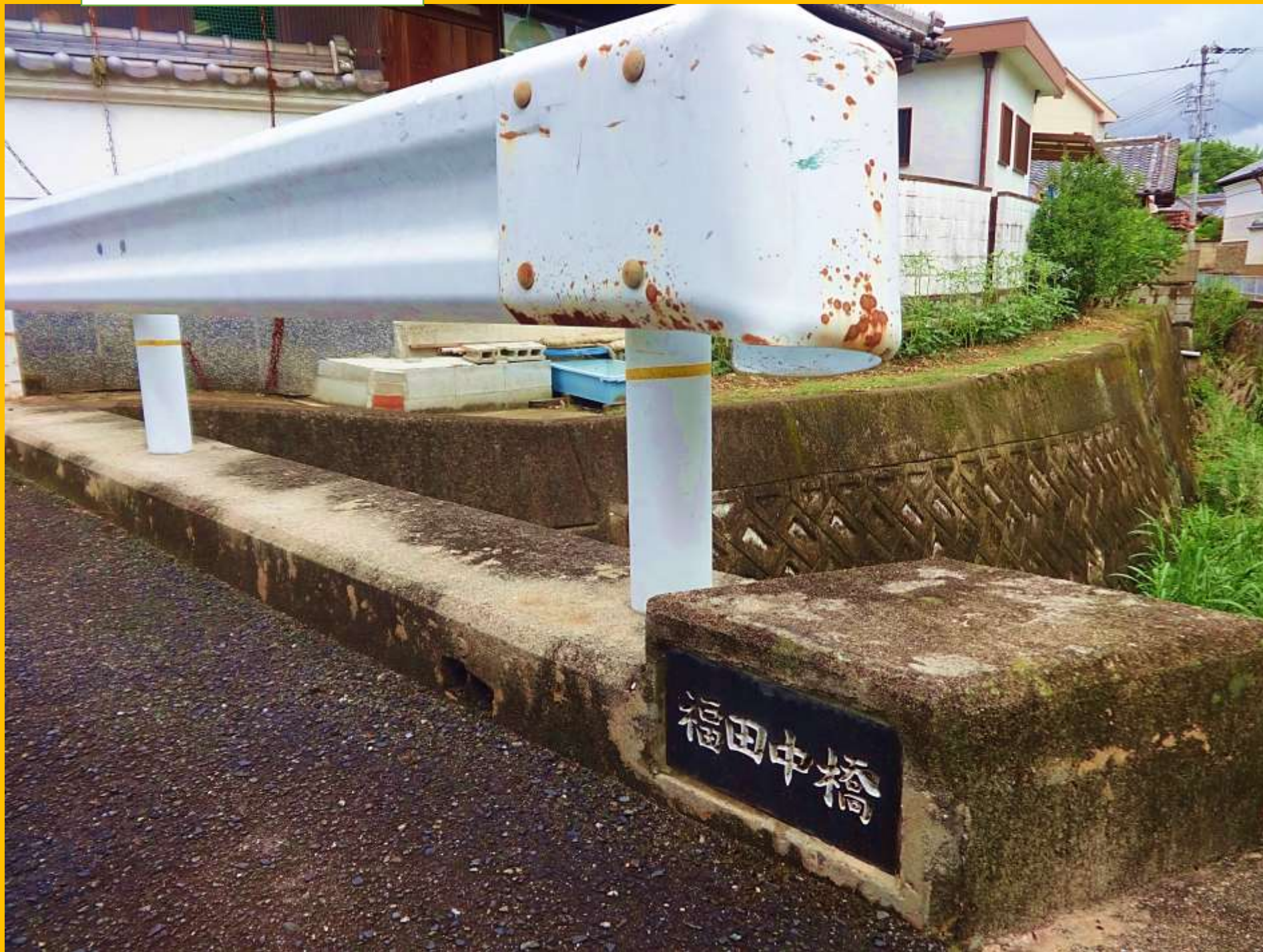
轟川にかかる橋 福田中橋
