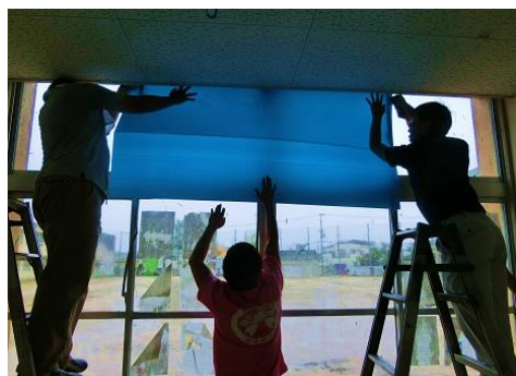
破損した窓ガラスを応急修理する職員
