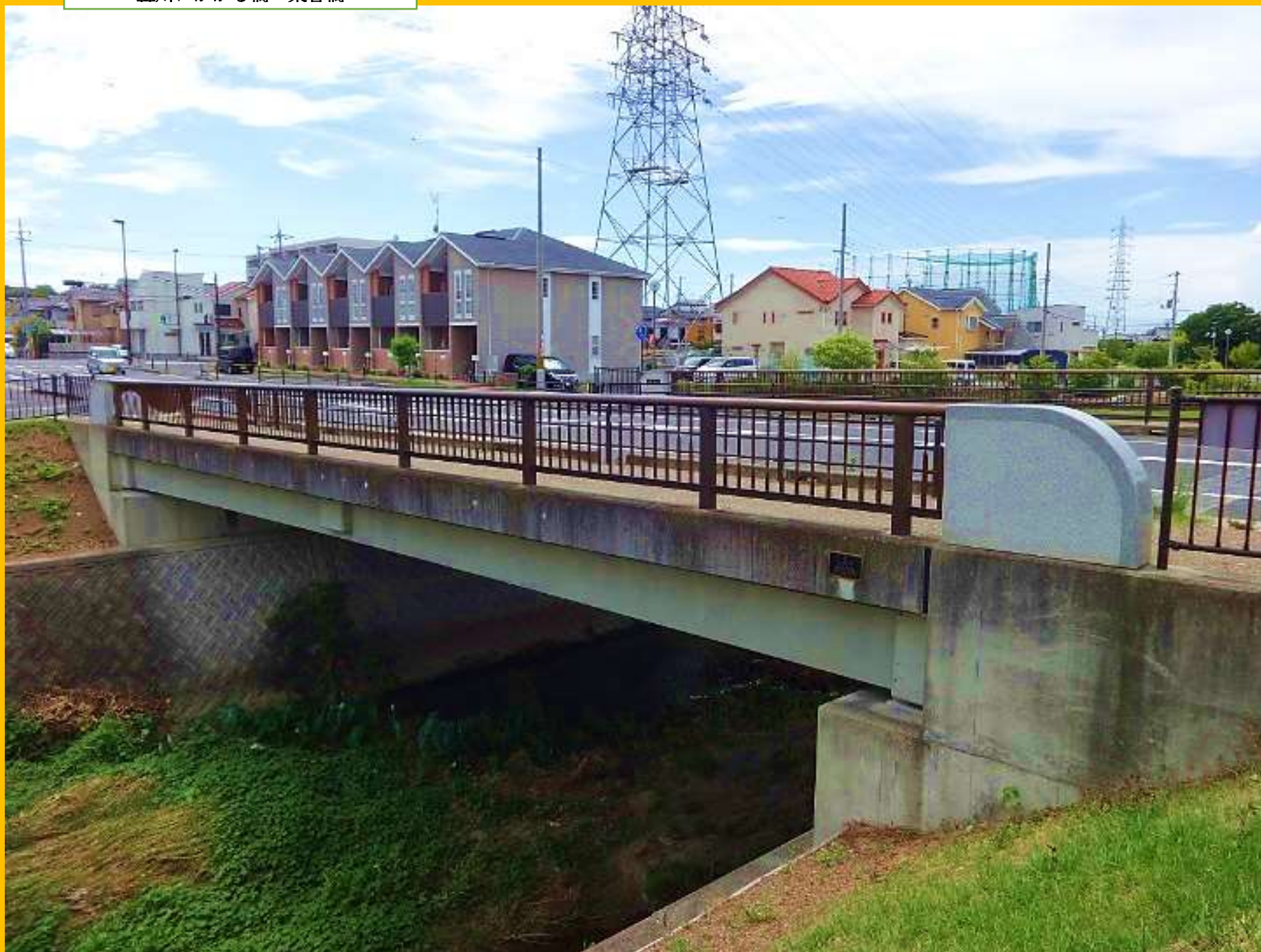
轟川にかかる橋 東谷橋
